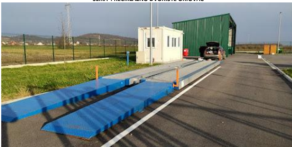
SLIKA : RECIKLAŽNO DVORIŠTE ORIOVAC
